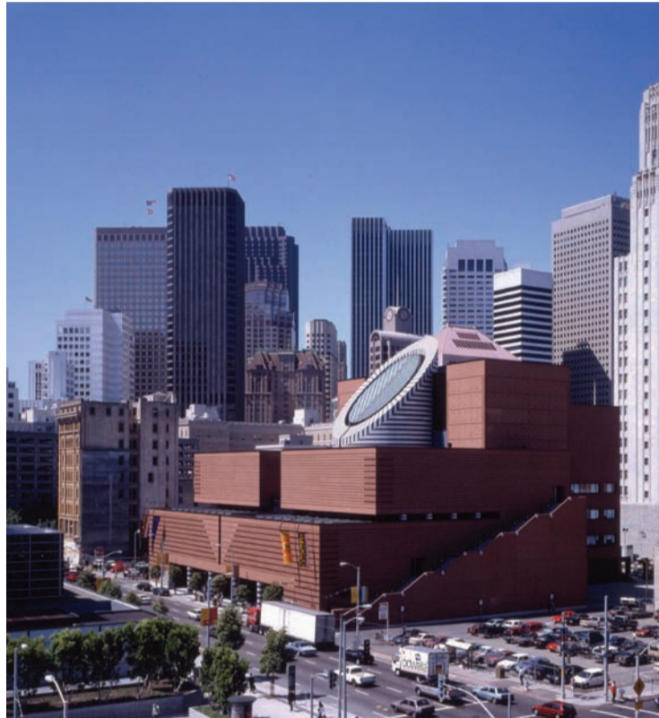
Come esprimere la creatività dentro un tessuto urbano circondato da giganti di cemento che sembrano fare la guardia? Ecco la sfida ed ecco la risposta che ha saputo trovare l'architetto Mario Botta per il Museo di arte moderna a San Francisco.
